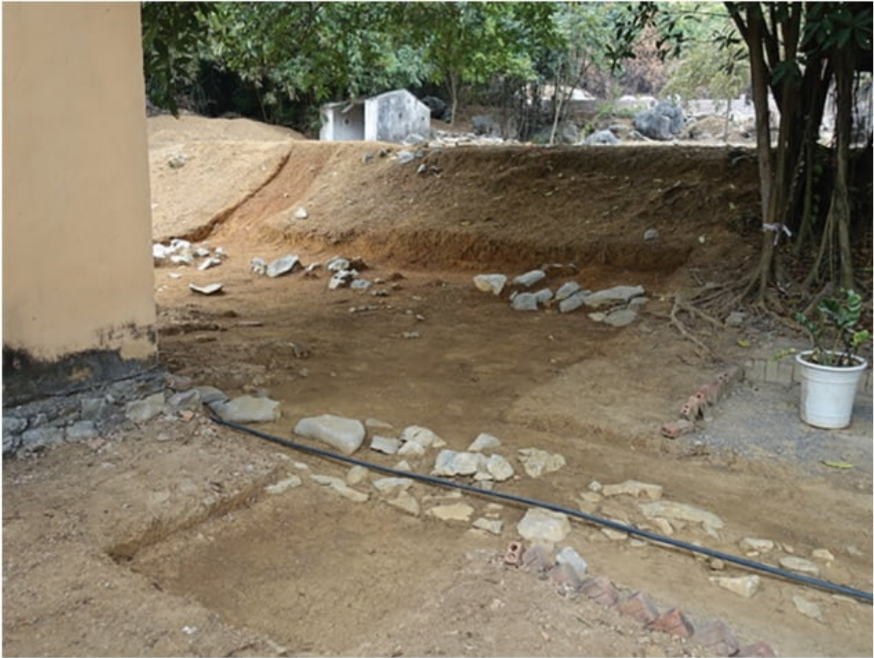
Dấu vết bó nền phía bắc chính điện Nghiêm Tịnh và bó nền của cấp nền thứ 3
