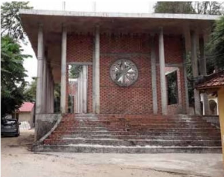
Chánh điện mới đang được xây dựng
